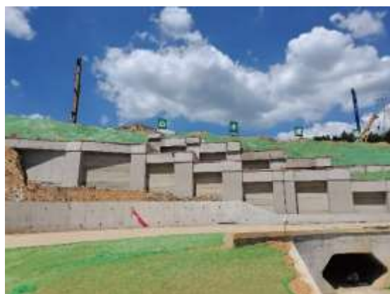
变电站区裸露地表苫盖照片
