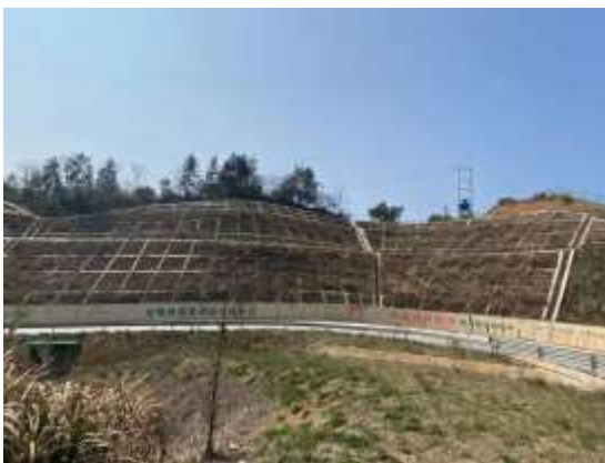
变电站区进站道路护坡工程照片
