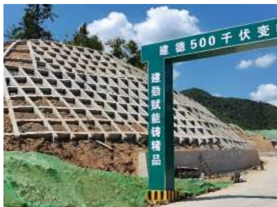
变电站区护坡工程照片
