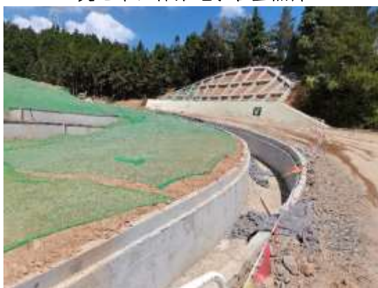
变电站进站道路边沟照片
