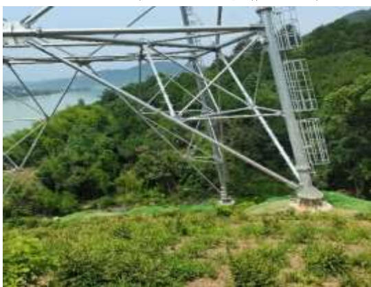
输电线路塔基底部绿化措施照片
