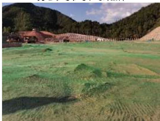
变电站站场区域内裸露地表苫盖照片
