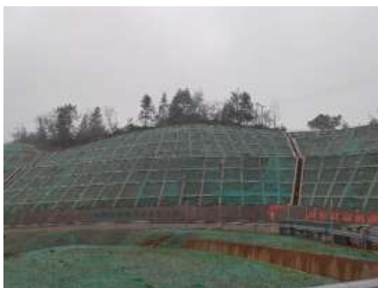
变电站区护坡工程照片
