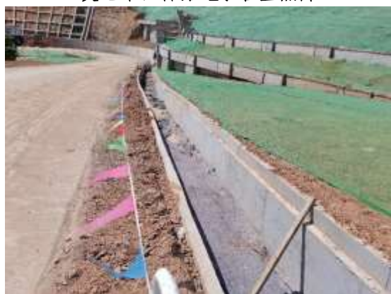
变电站进站道路边沟照片
