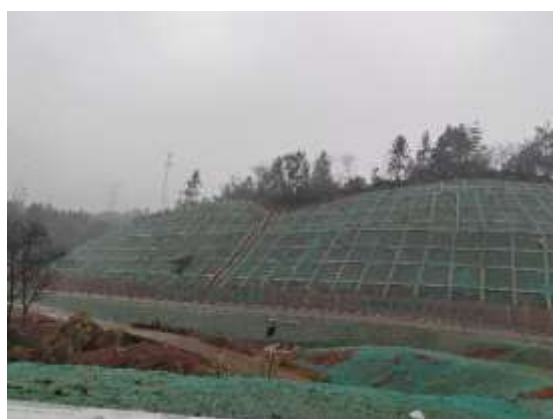
变电站进站道路外侧裸露地表苫盖照片
