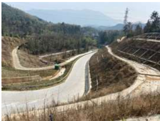
变电站区进站道路护坡工程照片
