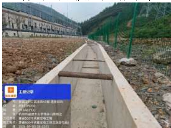
变电站外侧截洪沟措施照片
