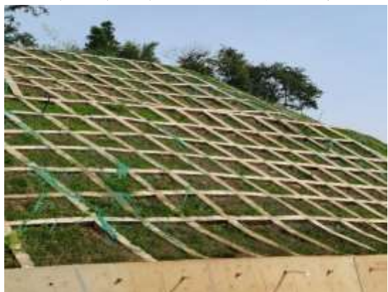
变电站边坡框格骨架植物措施照片
