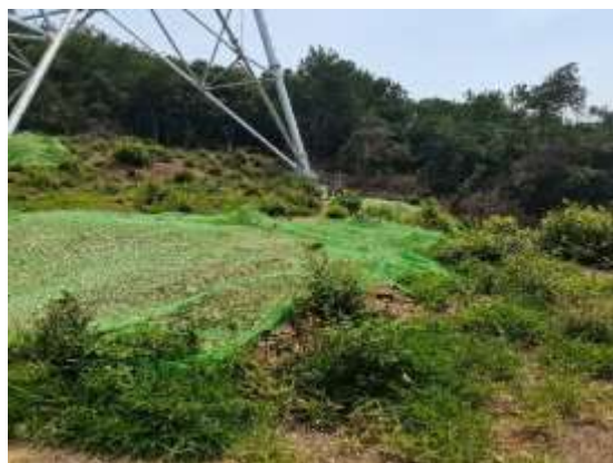
输电线路塔基底部绿化措施照片
