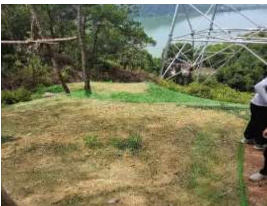
输电线路塔基裸露地表苫盖措施照片
