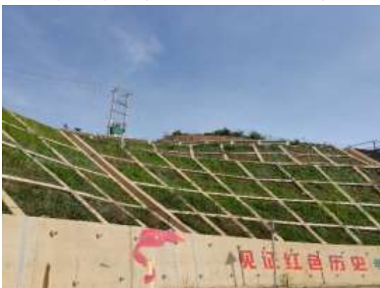
变电站边坡框格骨架植物措施照片
