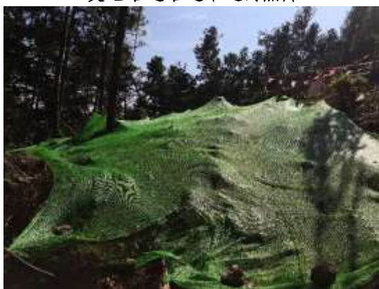
输电线路塔基区域内表土临时堆存苫盖照片
