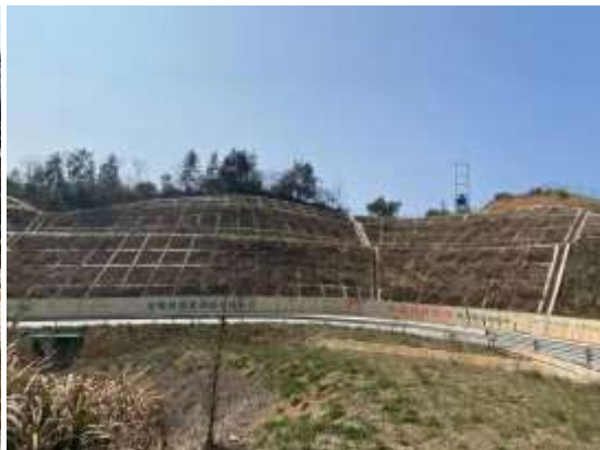
变电站区进站道路护坡工程照片
