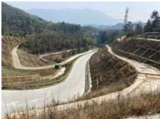
变电站区进站道路护坡工程照片
