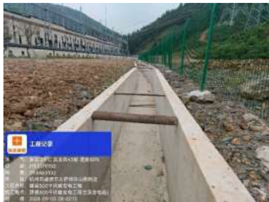
变电站外侧截洪沟措施照片
