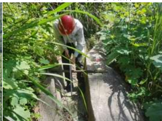
输电线路塔基排水沟照片
