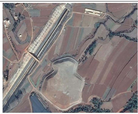
DK406+300 歌乐隧道出口渣场
