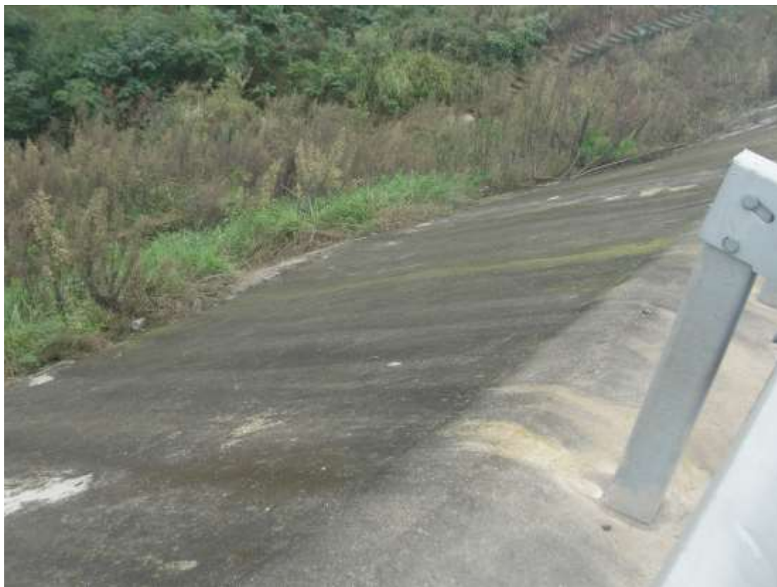
混凝土护面
