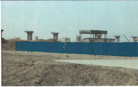
19 厂外区布设临时措施彩钢板拦档
