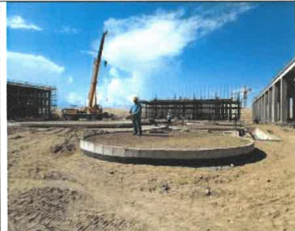
14 化水室外构筑物回填时洒水防止风蚀
