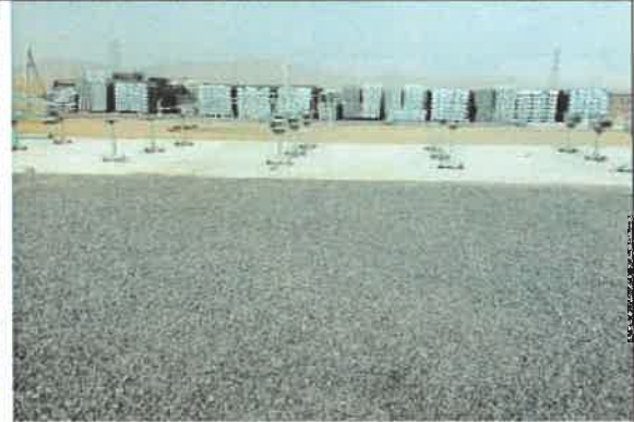
12 间冷塔安装加工场地面硬化及砾石压盖
