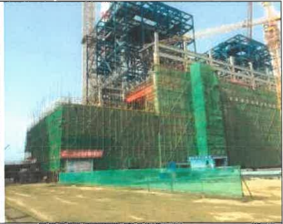
10 主场房建设风吹周围布设密目网防护
