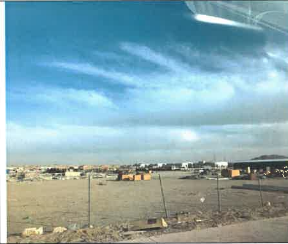
23 施工生产区清理迹地
