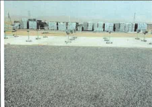
16 间冷塔安装加工场裸露地砾石压盖现场
