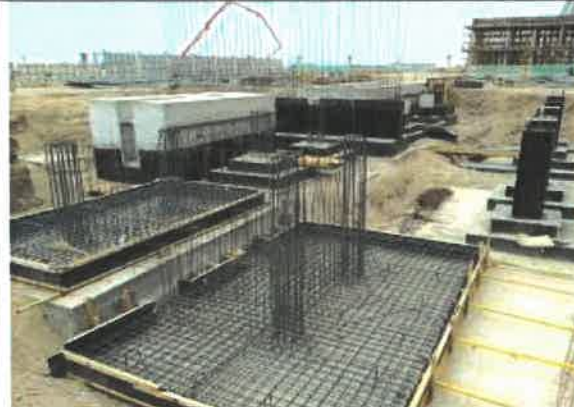
11 主变高压变土建施工周围布设密目网防护
