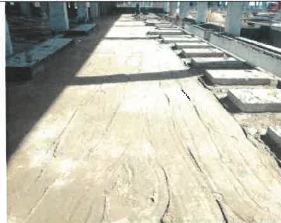
13 化验楼土方回填平整
