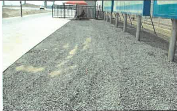
21 厂外道路区布设砾石压盖
