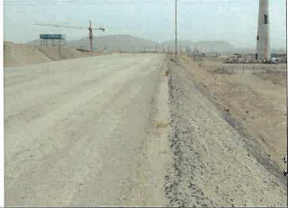
20 场外道路边坡布设砾石压盖
