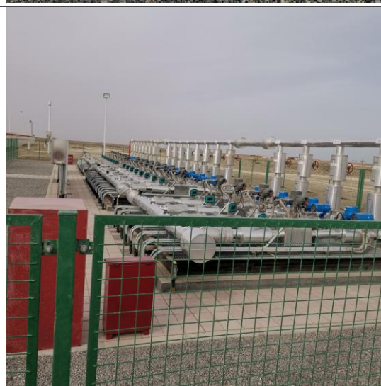
扩建阀组区域碎石压盖、机制砖铺设和土地平整
