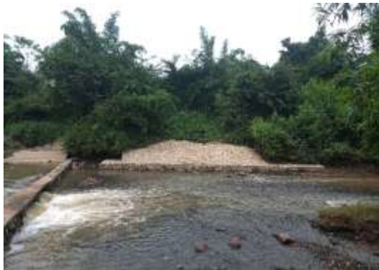
新江定穿越浆砌石护岸及挡墙
