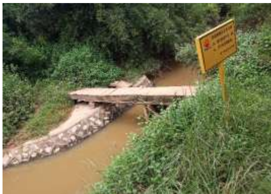
达做河大开挖穿越浆砌石护岸
