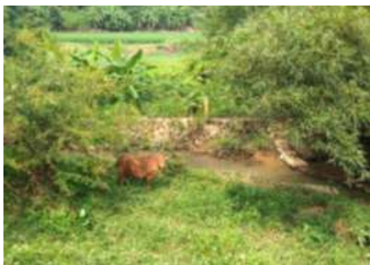
大开挖穿越小河浆砌石护岸及挡墙
